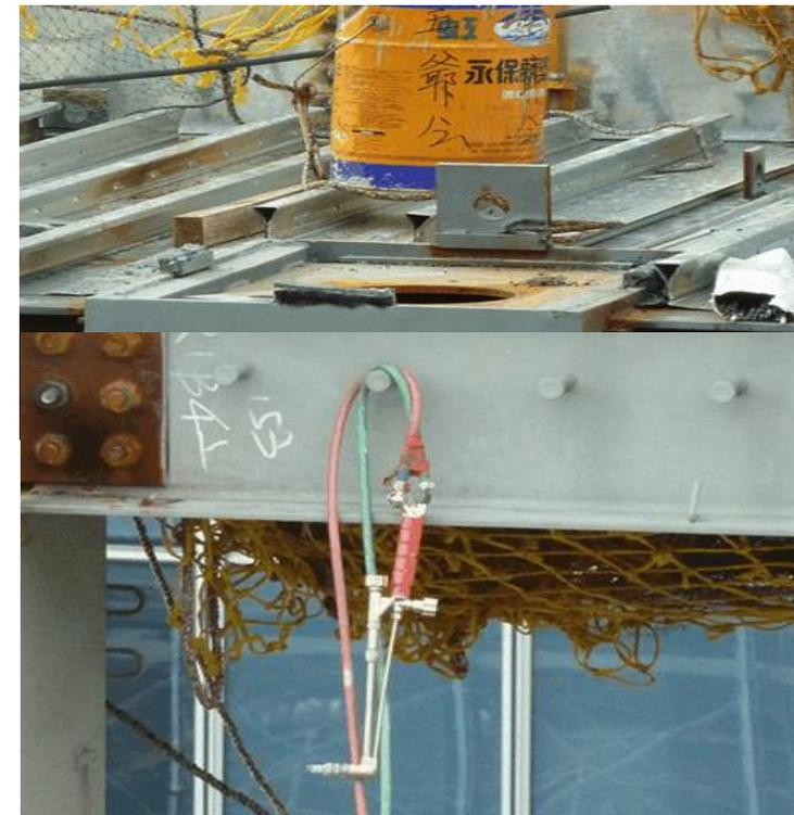
◎作業中斷時，將氧氣、乙炔之高壓管擱置於鋼柱上之中空圓洞上(活嘴朝洞內)，再去從事其他焊接作業，疑似未將供氣之開關關緊，造成鋼柱之圓洞內充滿氧氣、乙炔，再次點火時即發生爆炸，造成勞工臉部及胸口灼傷。
